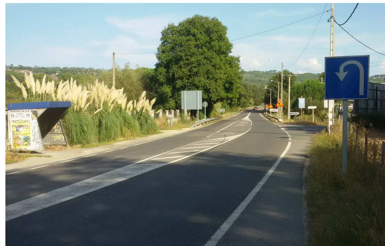
Imagen 2. Intersección y acceso actual a la Rúa Canizo .
