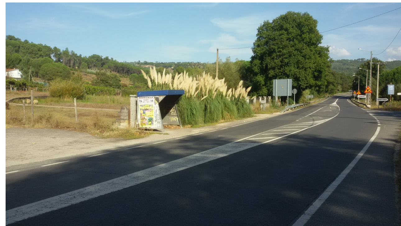
Imagen 8. Inexistencia de paso peatonal para acceder a la parada 1.1 de autobús de la OU-105 en el PK 0+825.
