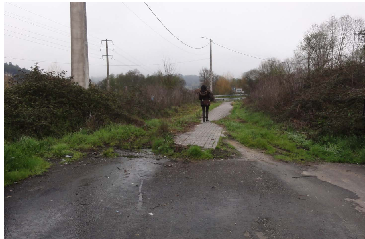
Imagen 6. Tramo final Rúa Canizo sin salida actual a la OU-105 para el tránsito de vehículos.
