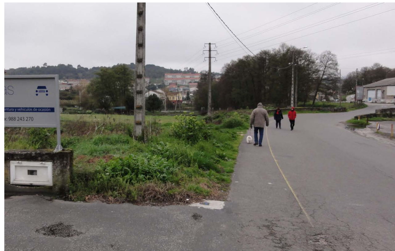
Imagen 5. Tramo Rúa Canizo sin continuidad en recorridos peatonales.
